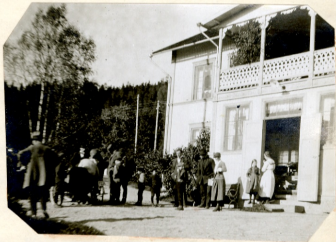
Kontrollstationen i Hassela.
